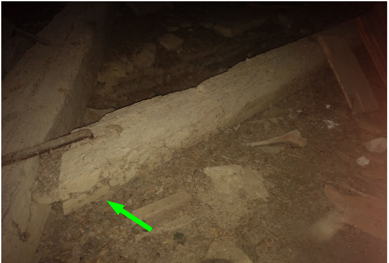
Typické poškodenie väzných trámov drevokazným hmyzom
